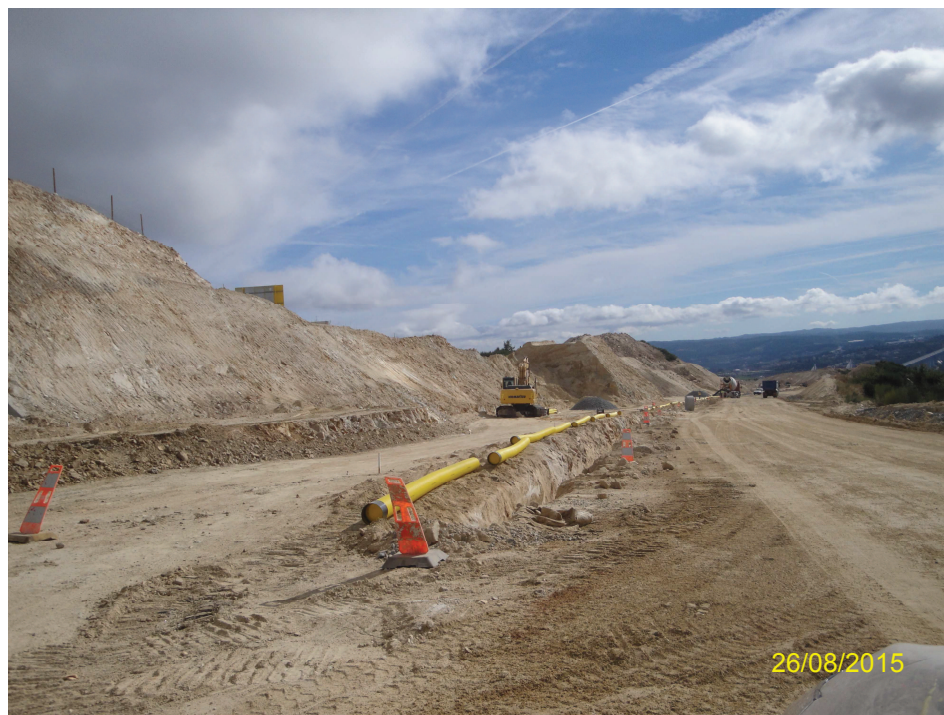
Registo Fotográfico 4 – Execução de drenos junto ao Pk 28+300
