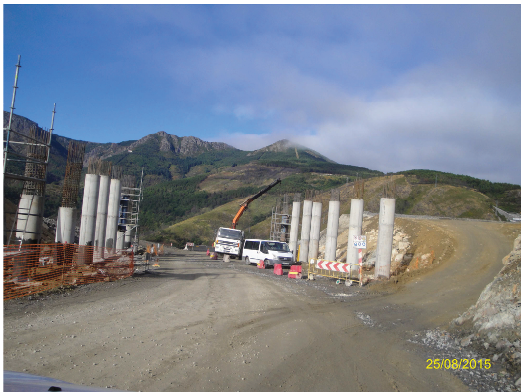
Registo Fotográfico 7 – Execução de pilares (PI7B), junto ao Pk 20+255
