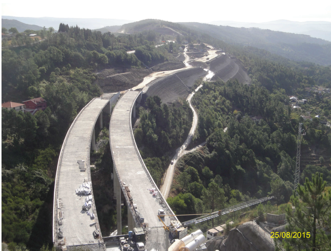
Registo Fotográfico 1 – Execução dos Muros em Solo-cimento M39 e M40 (Pk 20+200)
