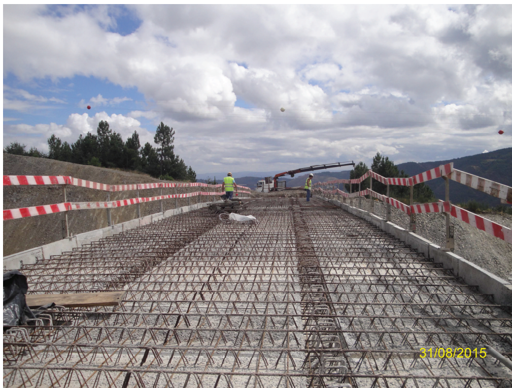
Registo Fotográfico 6 – Execução de Tabuleiro (PS9), junto ao Pk 20+900
