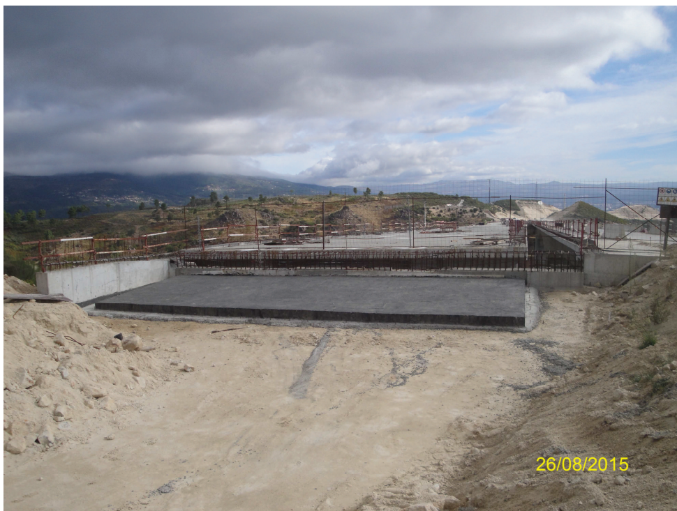
Registo Fotográfico 5 – Laje de Transição (Viaduto V12), junto ao Pk 27+600
