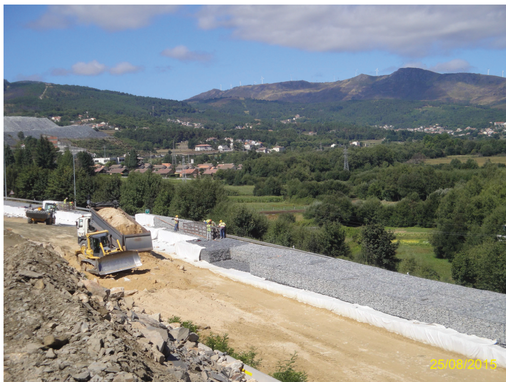
Registo Fotográfico 2 – Muros de Gabiões junto ao Restabelecimento 9D
