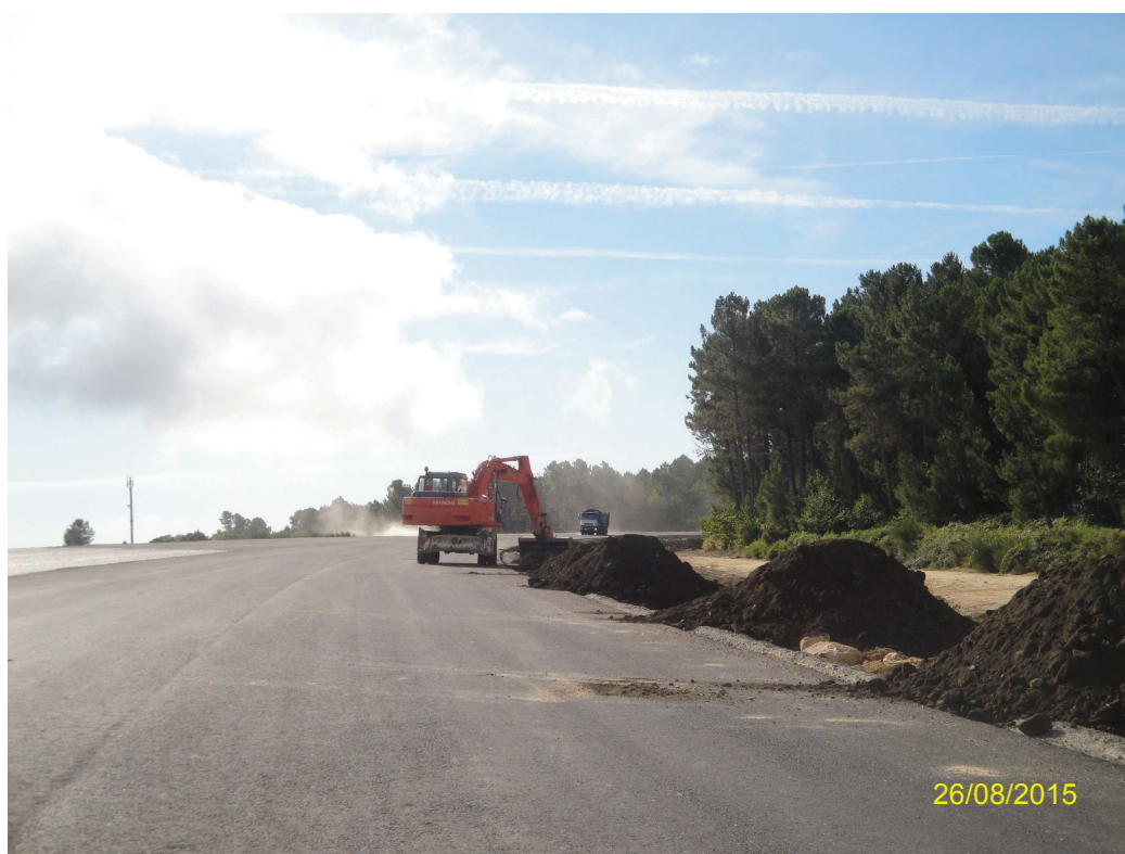
Registo Fotográfico 3 – Trabalhos de Colocação Terra Vegetal em Taludes ao Pk 23+850
