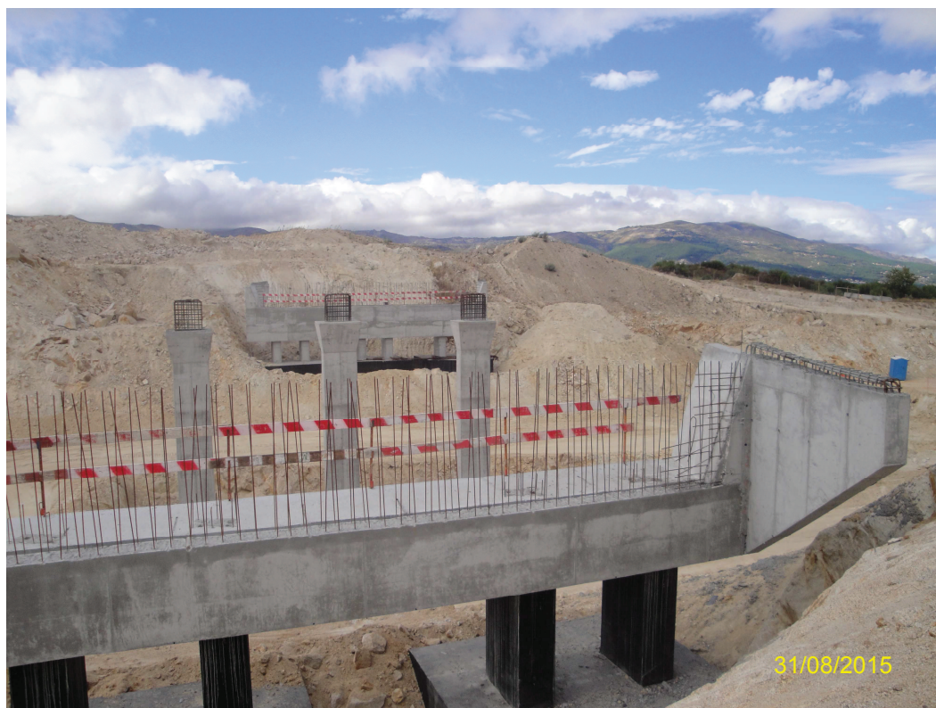
Registo Fotográfico 8 – Execução de Pilares e Viga Estribo (PS11A), junto ao Pk 29+300
